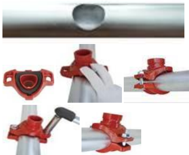
Рис.3. Установка отвода (седелка) под муфту на трубопровод.
